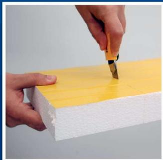
Corte de manera sencilla mediante un cúter o similar la pieza que precise.
