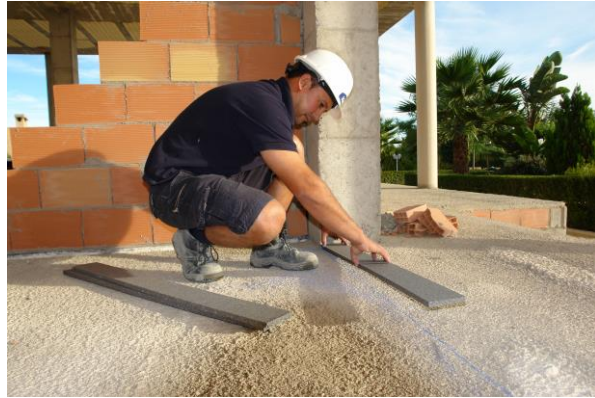
2- Fijar TR-0 Tiras al forjado, mediante elemento auxiliar (cemento cola, colas de pavimento, masillas,...materiales sin disolventes)
