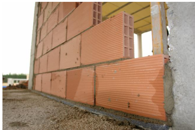
3- Levantar la hoja de ladrillos sobre la tira fijada al forjado. Siempre que sea la tira de EEPS 30 mm más grande que la hoja de ladrillo, así la pellada de cemento no tocará el forjado y será realmente un tabique flotante.
