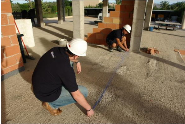
1- Replanteo en obra
