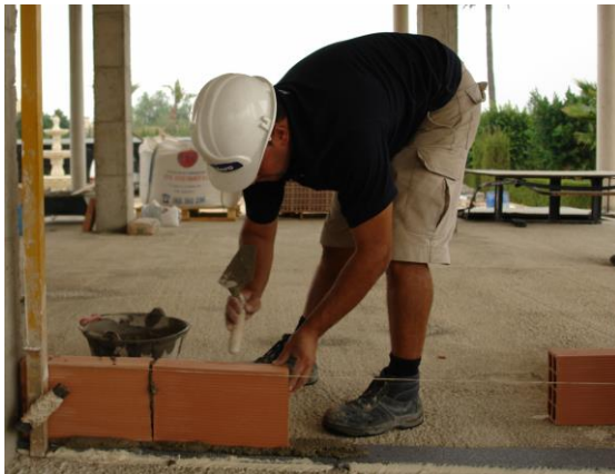
3- Levantar la hoja de ladrillos sobre la tira fijada al forjado. Siempre que sea la tira de EEPS 30 mm más grande que la hoja de ladrillo, así la pellada de cemento no tocará el forjado y será realmente un tabique flotante.
